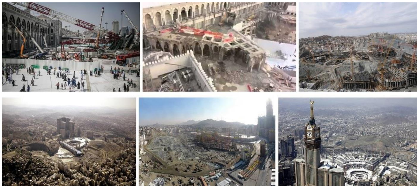
Quelques témoignages du gigantisme des travaux (et des fouilles) conduits récemment par les Saoudiens à La Mecque
